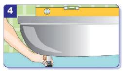
Die Duschwanne mit der Wasserwaage ausrichten. Die Duschwanne erhält ausreichende Standfestigkeit durch Montage der speziellen Haltewinkel.
